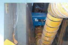
負圧防塵機設置
