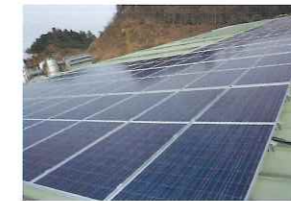
太陽光発電装置設置(エコランドキムラ)
