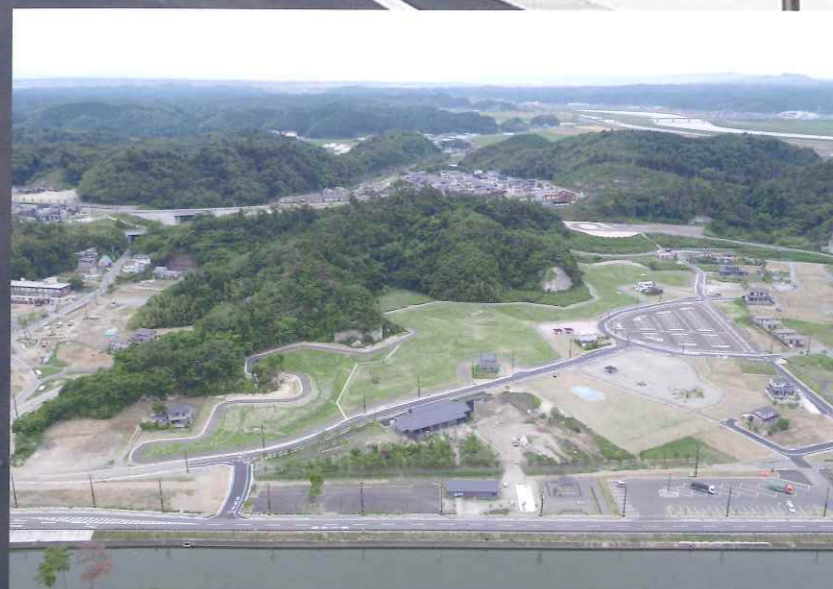
▲奥松島運動公園災害復旧工事（マレットゴルフ場外）
