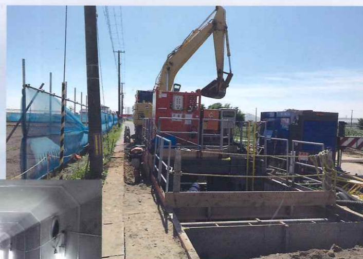
▲大曲排水区 下水道管渠工事（オープンシールド工法）
