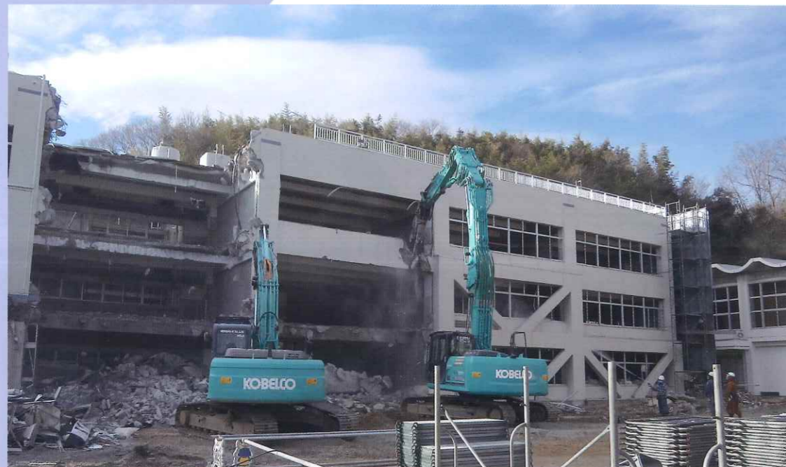
▲鉄筋コンクリート造 学校解体工事
