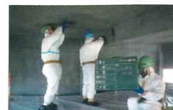
アスベスト除去作業
