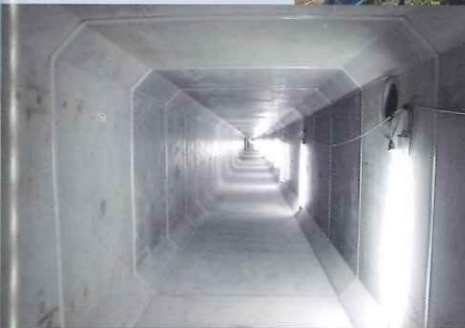
▲大曲排水区 下水道函渠工事
