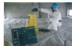
アスベスト袋詰め作業
