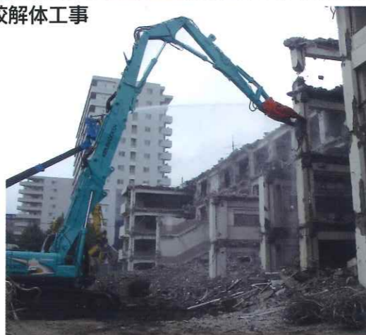
▲鉄筋コンクリート造 解体工事
