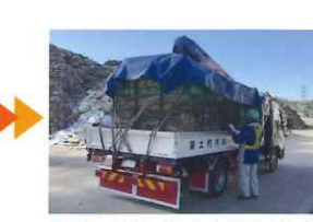
3 検収を受け、指定箇所へ移動して積み荷を降ろす
