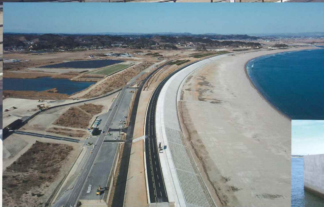
▲州崎道路改良工事
